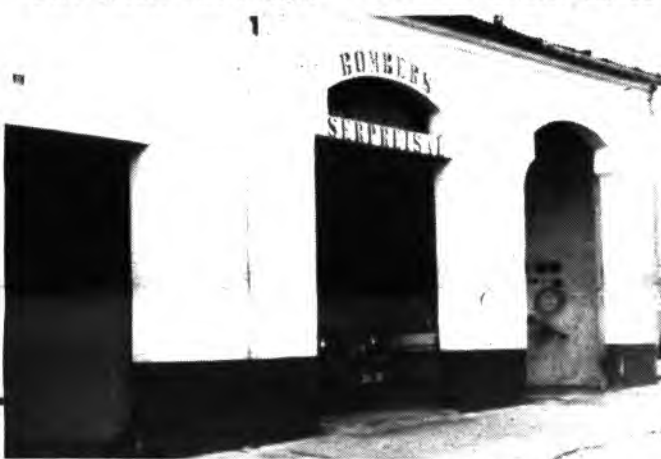
Detalle de las cocheras del parque de bomberos.
