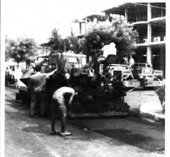
Detalle del asfaltado. (Foto: Payeras).
