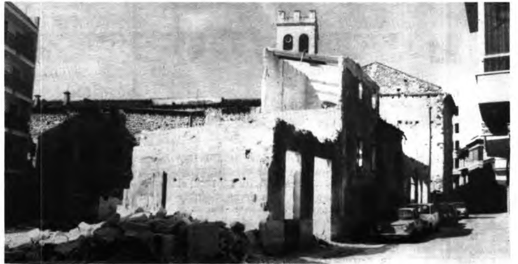
Detalles de la reforma de la calle Almogávares.
