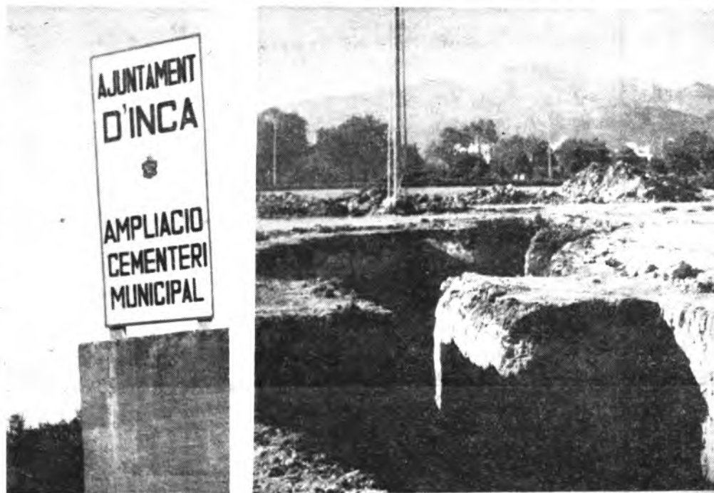
Detalle del estado actual de las obras (Foto: J. Riera)
