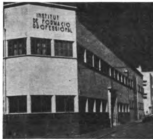
Detalle de la fachada del Centro.
