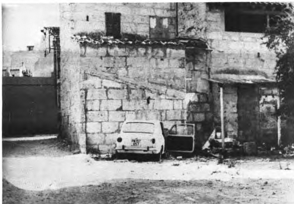
Junto al antiguo cuartel de la Guardia Civil, el comienzo de esta calle. Está sin asfaltar debido a una reforma que se tiene que hacer. Parece más un torrente en sus primeros metros que una calle. ¿Cuándo se realizará esta reforma y arreglo de la calle? Foto J. Riera.
