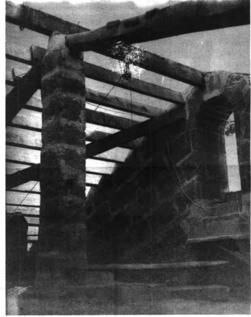
Debajo de este entramado de vigas de madera, se halla el Altar Mayor.
