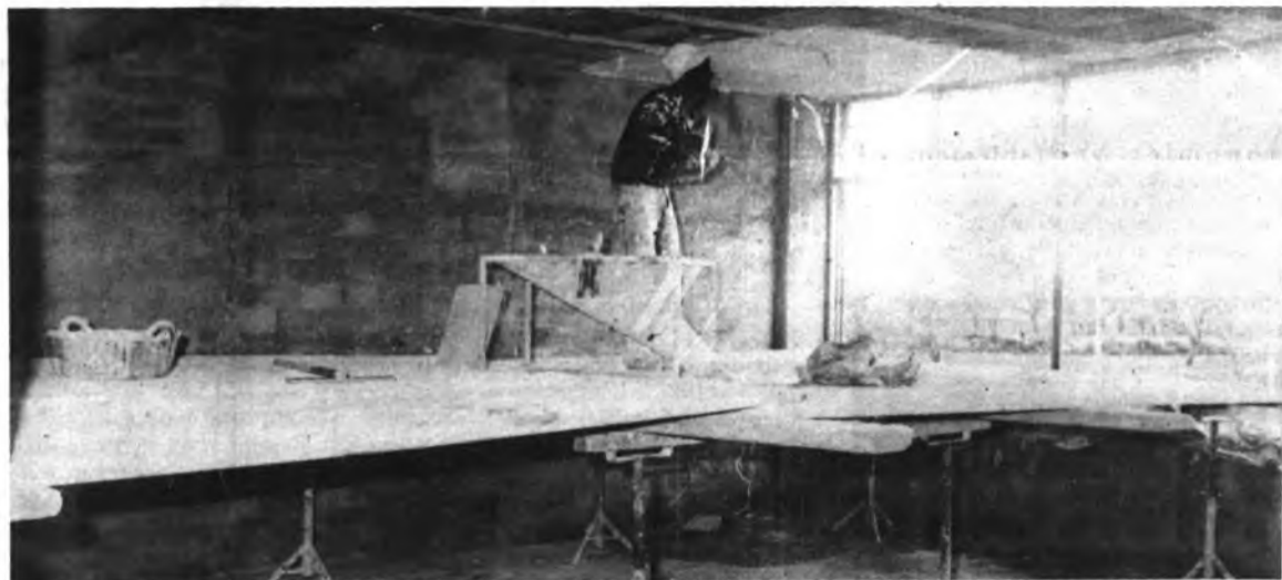
Los albañiles, electricistas, yeseros están ultimando las aulas de preescolar.
