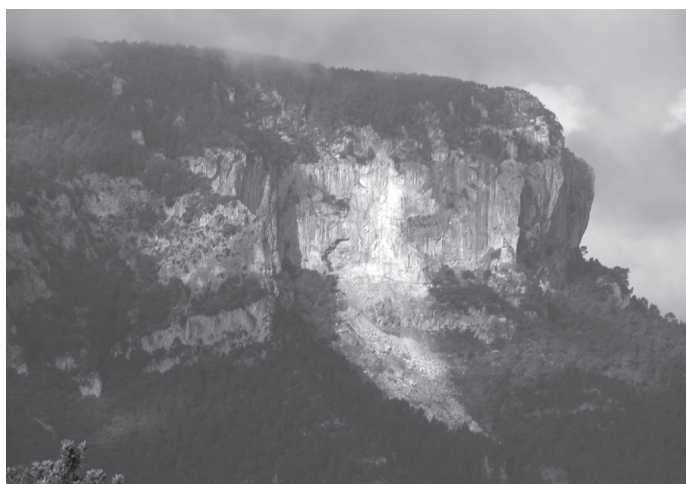
VEGEU LES DIMENSIONS DEL DESPRENIMENT.
