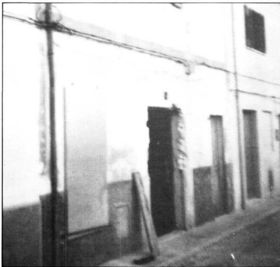
Ca sa Molinera avui: la botiga tancada, i la casa en obres
