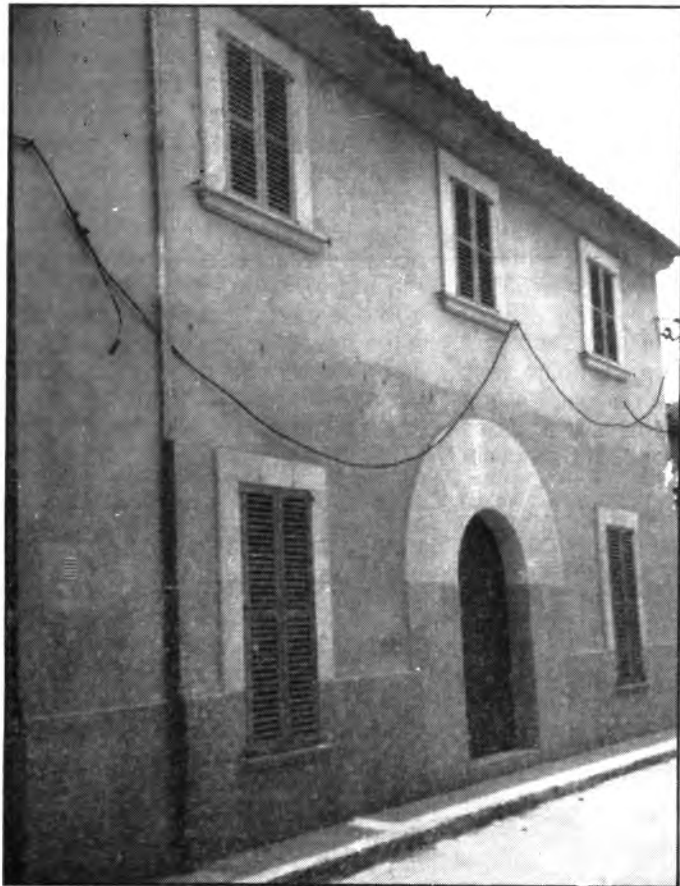
Façana d'una casa restaurada per n'Obrador
