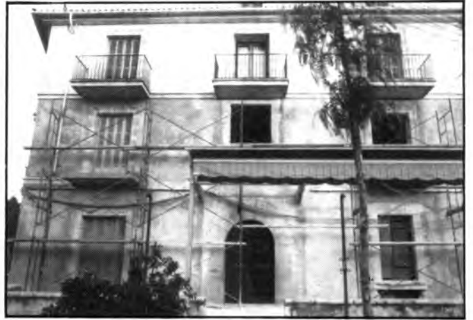
Ca'n Quelet en el moment d'iniciar-se les darreres obres de reforma. Estiu 1.987
