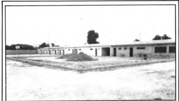
Ja han començat les obres de la segona pista de bàsquet al camp municipal.
