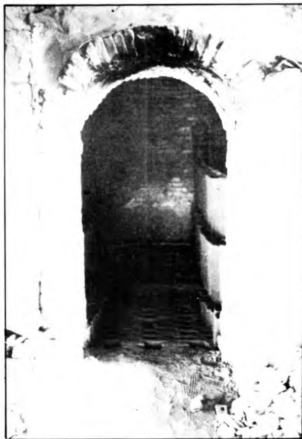
Boca del forn moro de sa teulera. En terra podem veure els forats del reixat per on puja el foc des del cendrer.
