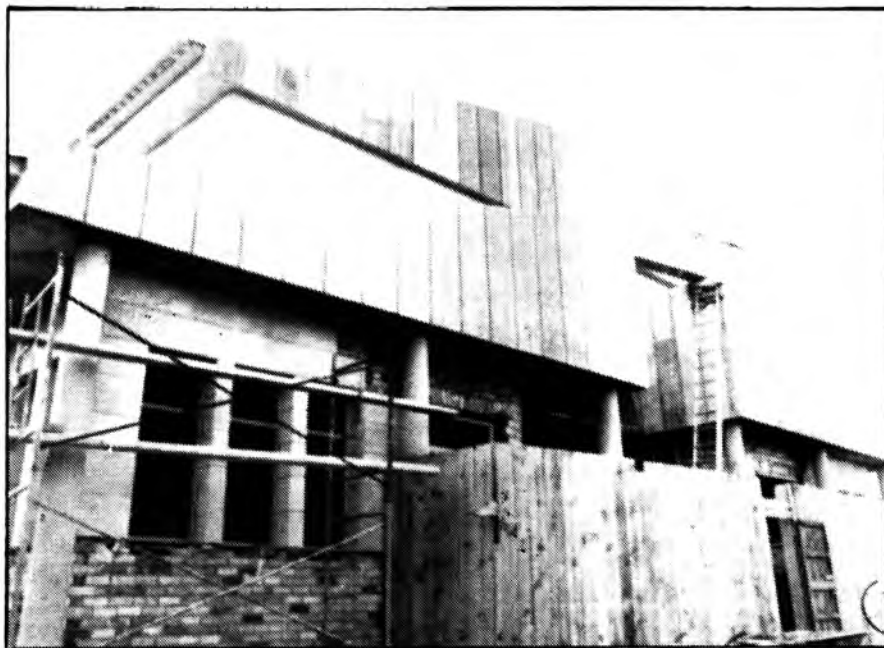
L'Edifici Municipal, actualment en fase de construcció, és obra d'Emili Gené.
