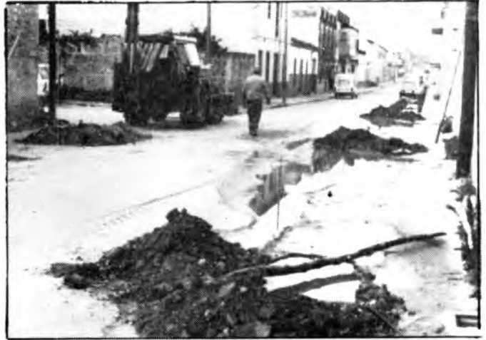
Fent els clots per sembrar els arbres es va foradar una tuberia de l'aigua.
