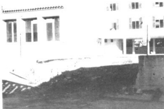
L'escola de Llubí en obres.
