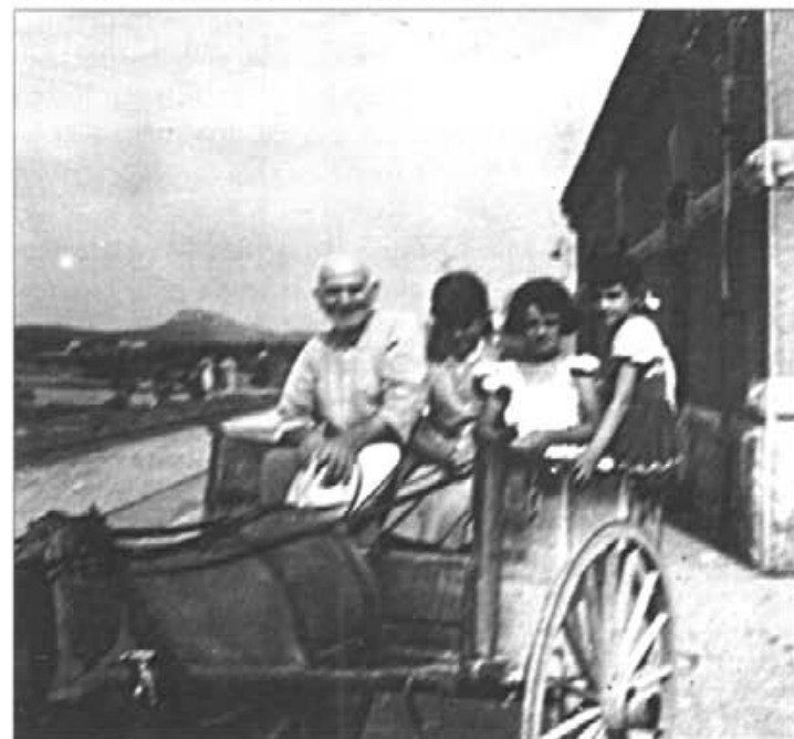
L'amo en Joan Solaies davant l'estació de Sant Llorenç
