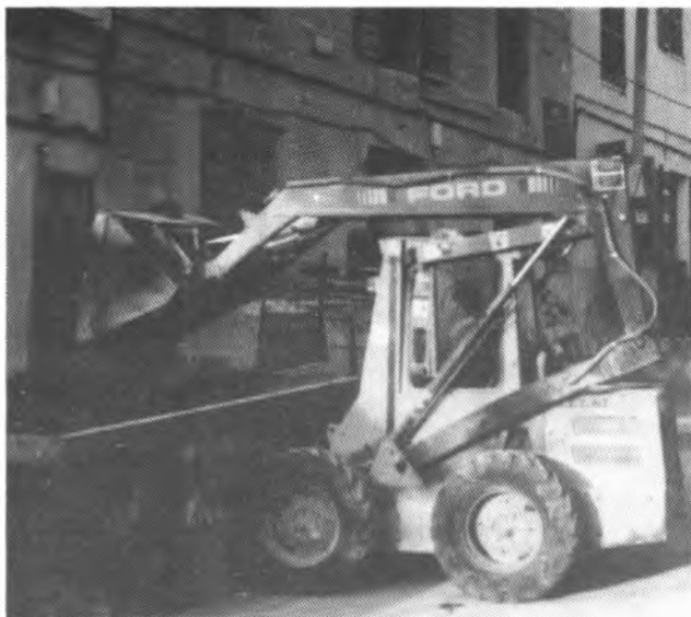
Aspecte de les obres del futur centre sanitari.
