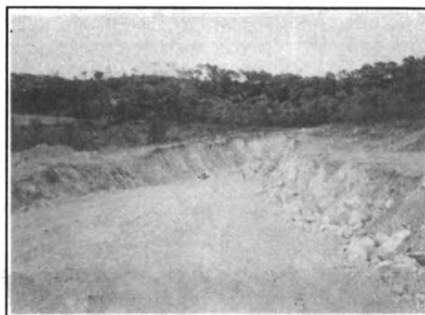
Començament de la perforació del Coll des Vidriers.
