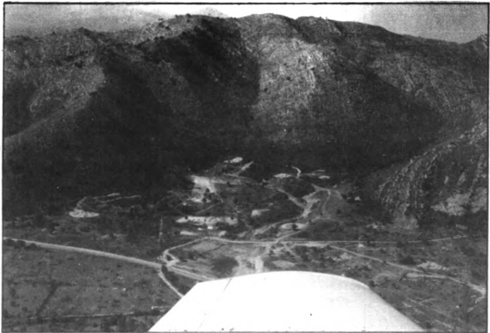
COMELLAR DE SOS SASTRES VISTA PARCIAL DEL CAMP DE GOLF EN CONSTRUCCIO.
