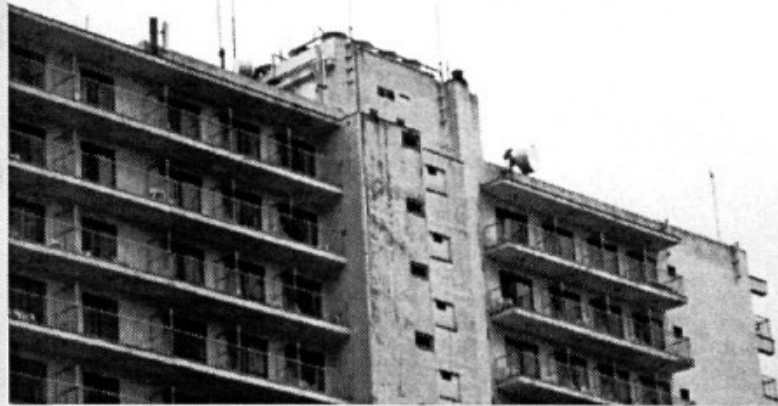
Los MoviLineros de Can Picafort, ya pueden estar bien tranquilos, pues en el hotel Tonga Sol sirve de base para este nuevo repetidor instalado por telefónica
