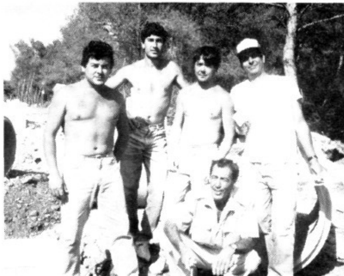
Un grupo de trabajadores de la reforma de la entrada a Can Picafort en el tramo Baulopins hasta la carretera Artà-Alcúdia. Son Gabriel Martín, José Toni Peláez, Gonzalo Vallejo, Pedro Jiménez y José Rodríguez, pertenecientes a la empresa de Construcción Pedro Sansó. Esta temporada les vemos cada día agachados, y dándole fuerte a esas nuevas largas aceras de ese tramo de carretera por donde dentro de poco podremos nosotros pasear con toda tranquilidad. Nuestro homenaje a ellos.
