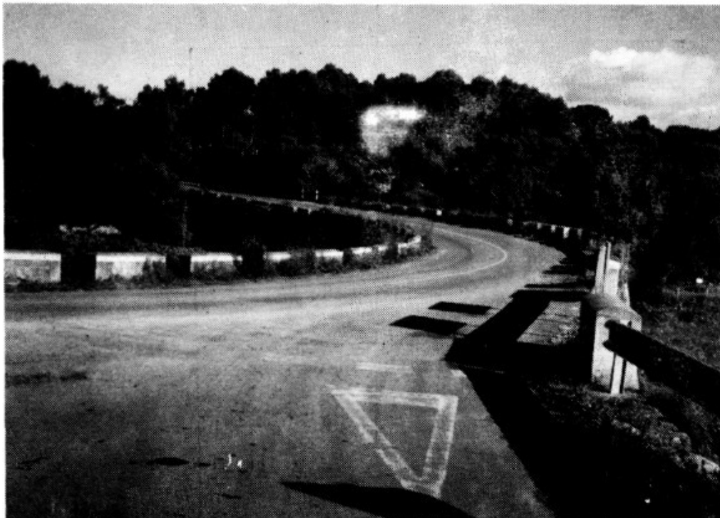
La peligrosa curva del puente del Torrente de Son Real
