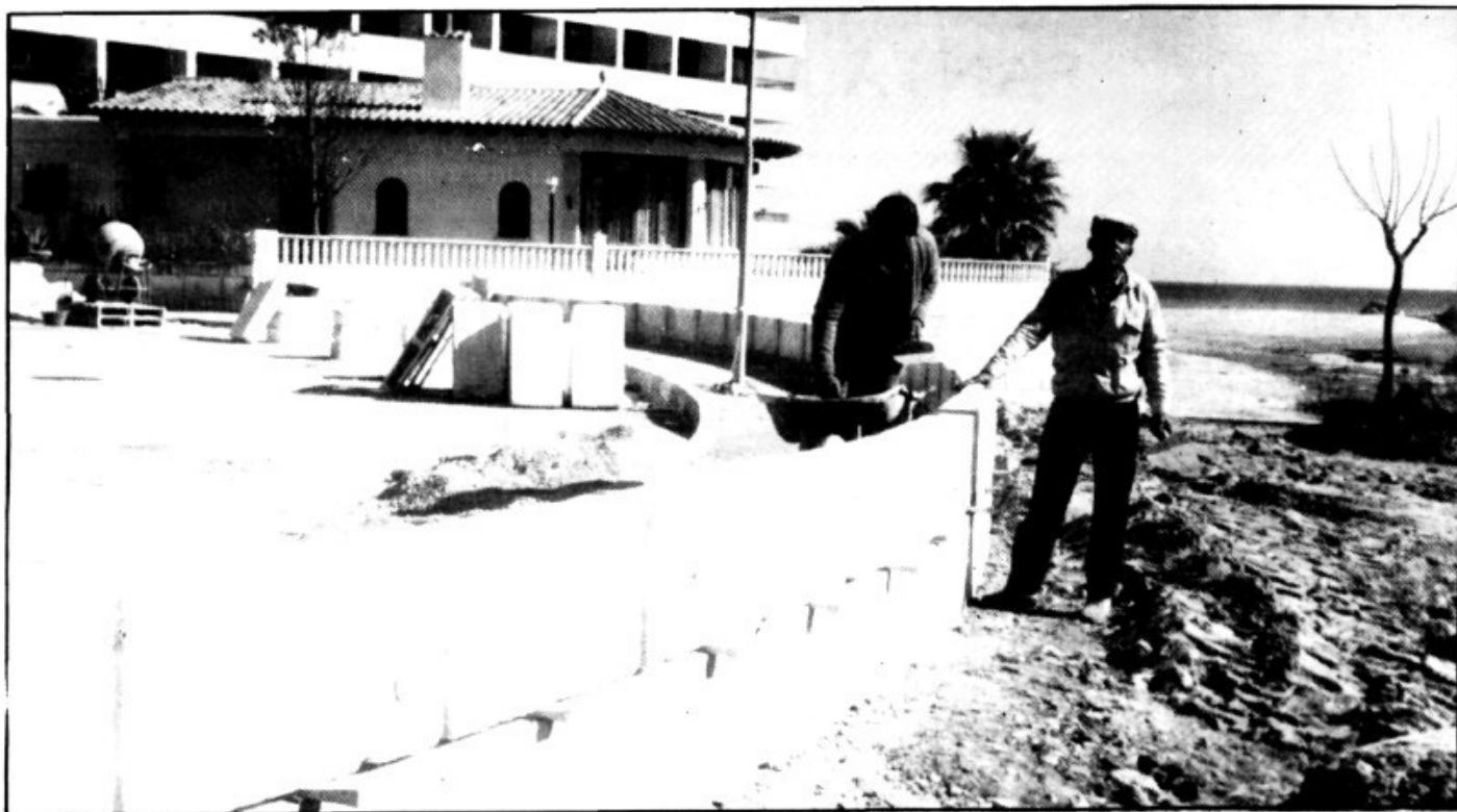
Reforma en la Plaza de Son Bauló
