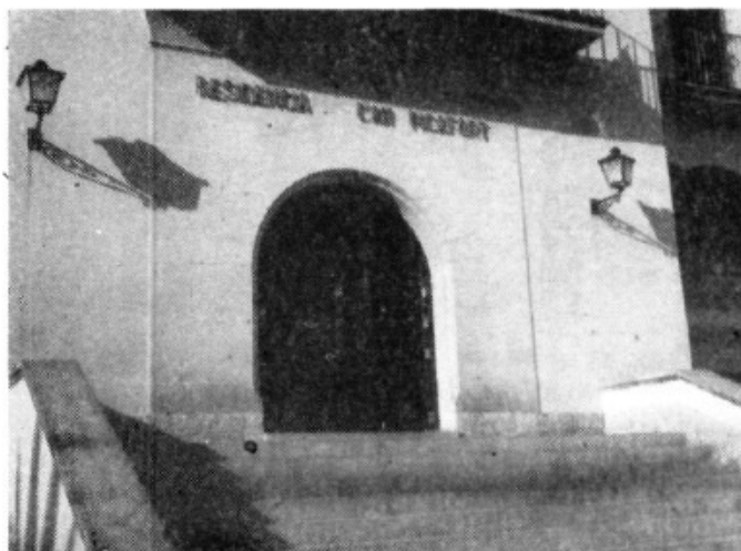
Residencia de Can Picafort. Entrada Principal.
