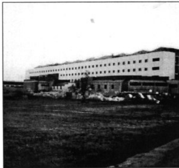
Hospital Comarcal de Manacor.
