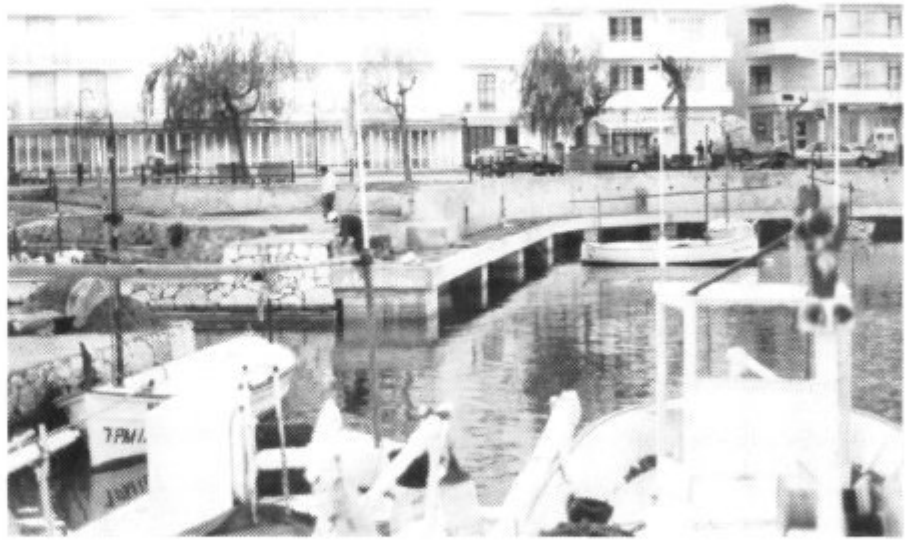
Nuevas obras en el Puerto de Cala Bona.
