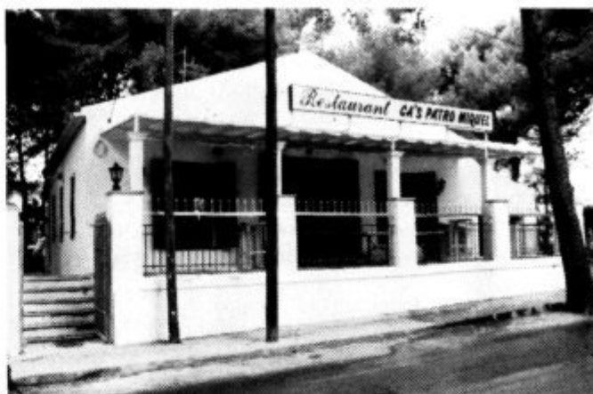
Fachada del nuevo Restaurante de Miguel Gelabert.
