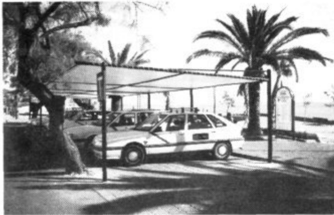
La nueva parada de taxis y la marquesina recién instalada
