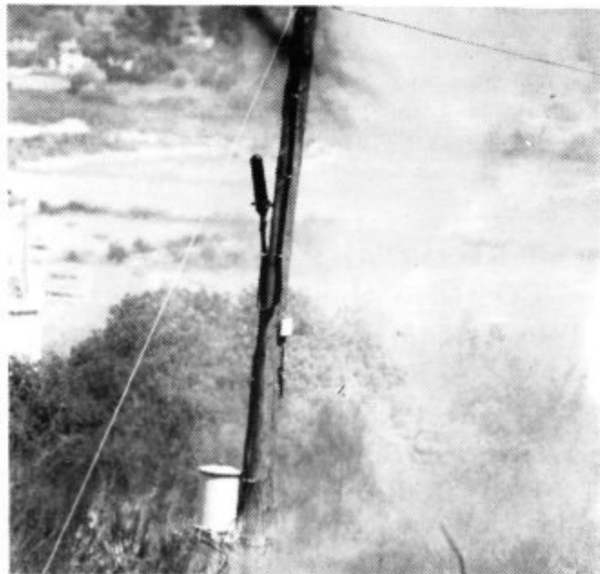
El incendio se pudo extinguir gracias a la rápida intervención
