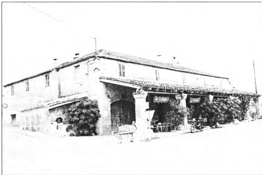
La primera central elèctrica de Montuïri s'instal·là el 1914 a s'Hostal
