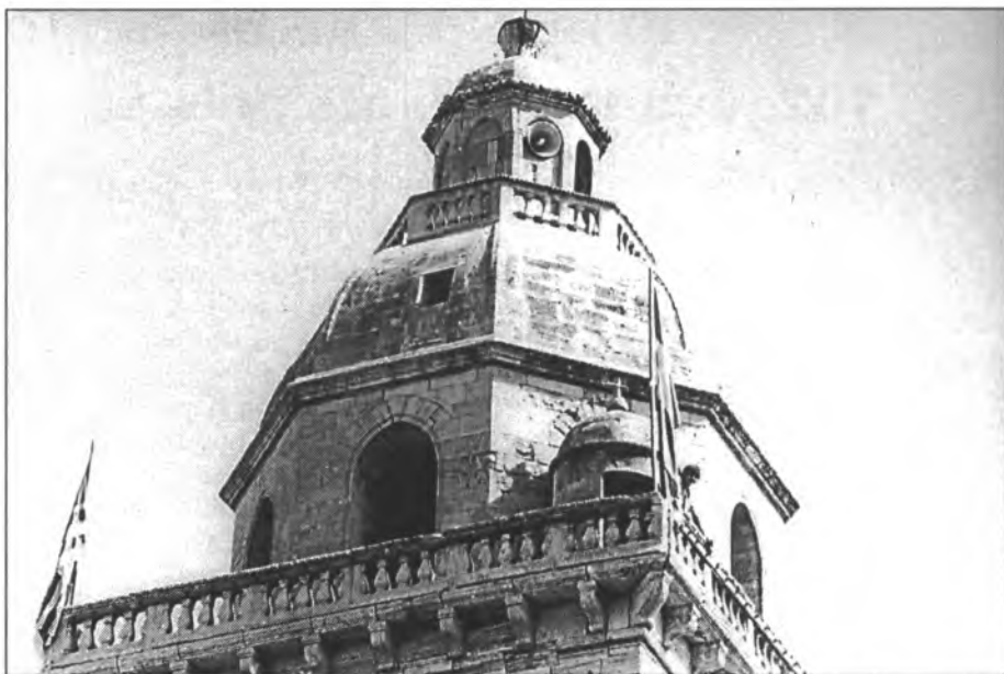
El campanar dies abans de Sant Bartomeu de 1983. Ara, transcorreguts 20 anys, les baranes encara estan molt més deteriorades degut a la multitud de coloms que amb les seves deposicions l'espenyen de cada dia més. La solució es fa necessària com més prest millor
