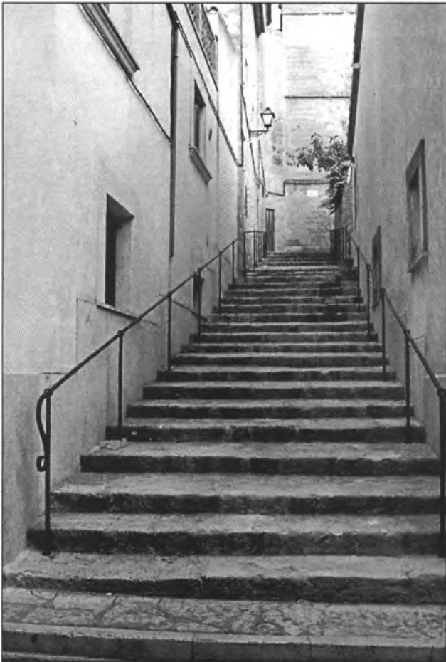
Detall de l'escalonada de darrera el campanar amb els arribadors col·locats
