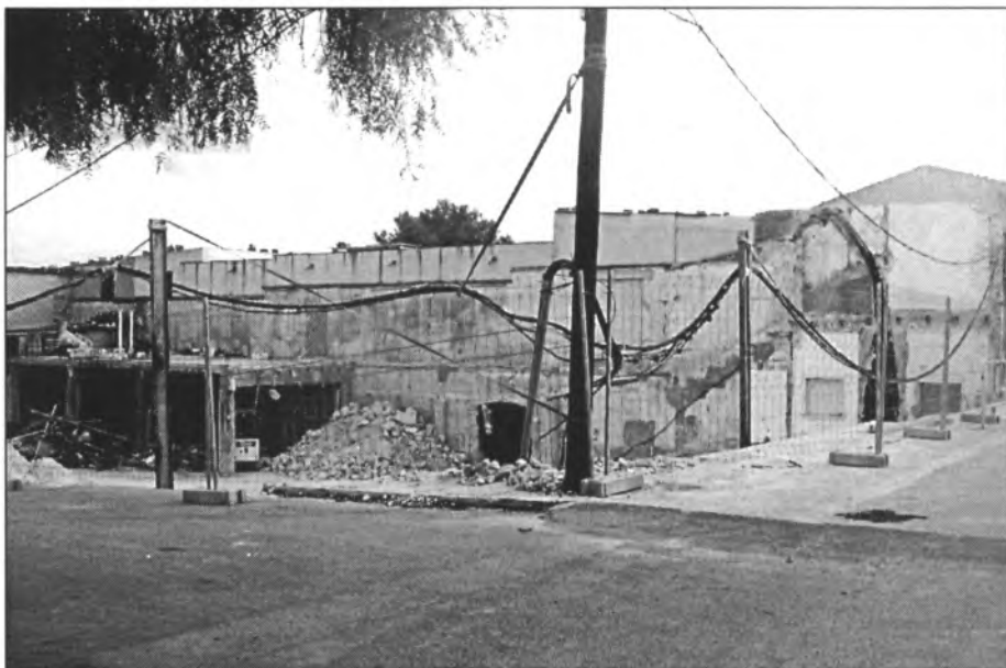
En el solar on hi havia l'antiga plaça de toros de Montuïri, després de ser totalment enderrocada s'hi han començat a construir vivendes de nova planta
