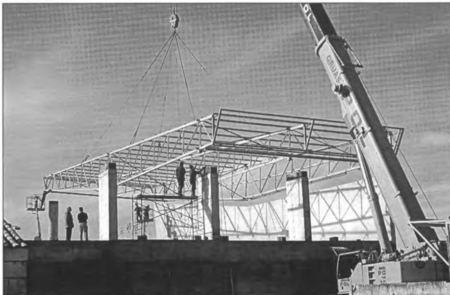
Tècnics i obrers en plena sessió de treball en el moment en què una gran grua acabava de dipositar la coberta damunt la paret i columnes que l'han de sostenir
