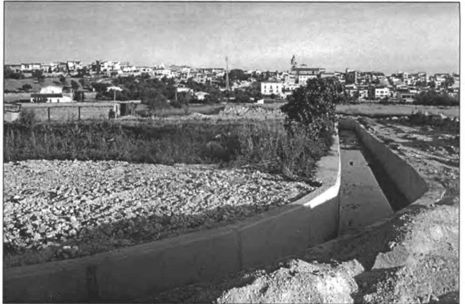
La siquia del Camí Pelut ha sofert una considerable millora
