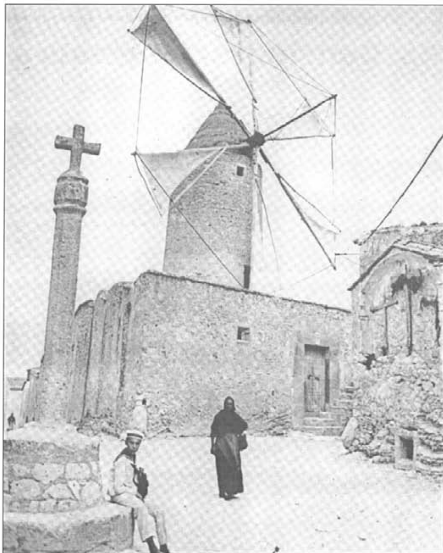
"Quan es va instal·lar l'electricitat a Montuïri, en els murs de les cantonades fou necessari fixar-hi mènsules metàl·liques per subjectar-hi els aïlladors que sostenien els fils de coure", tal com es destria en aquesta foto de l'any 1920, quan encara el molí de Can Vermell aguantava les aspes
