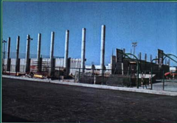
Les obres el pavelló cobert continuen a bon ritme
