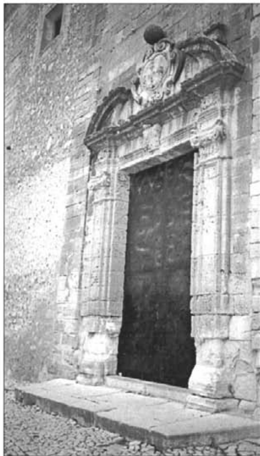
Està previst que prest comencin les obres de rehabilitació del portal dels homes
