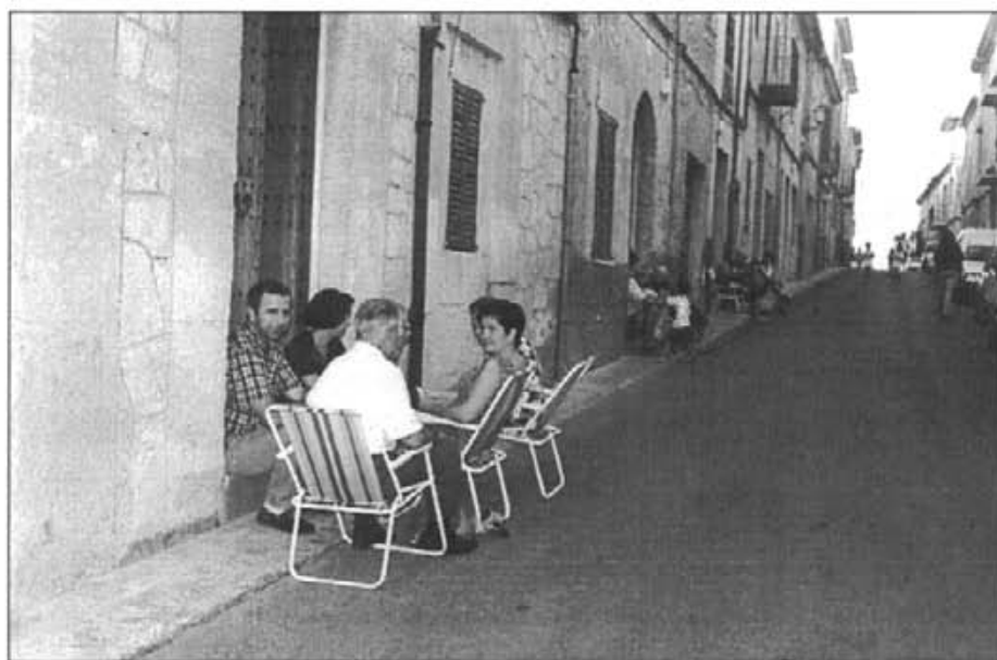
La ferreria del ferrer d'Alcoraia va estar molts d'anys al carrer des Pujol
