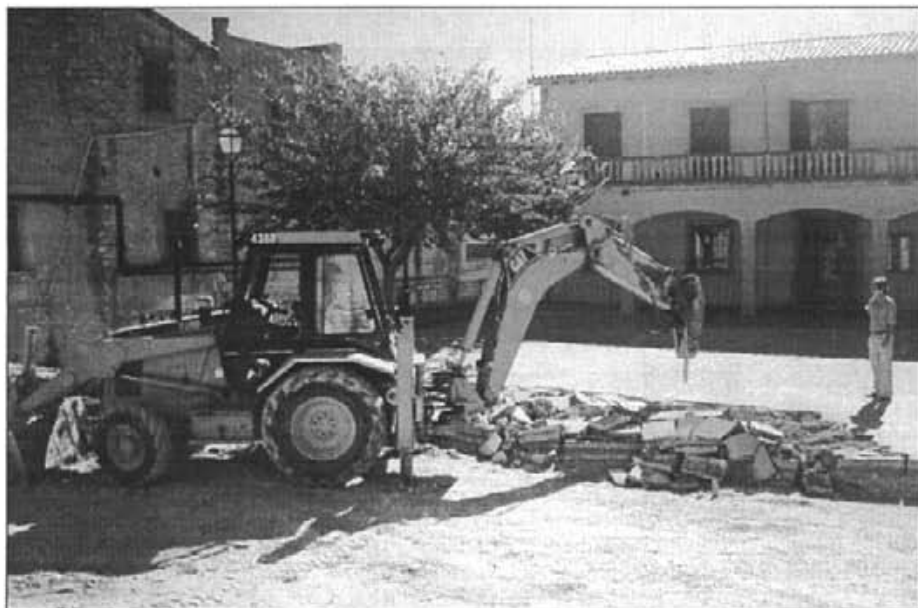
A la màquina excavadora li varen bastar dos dies per aixecar tot el trespol de plaça
