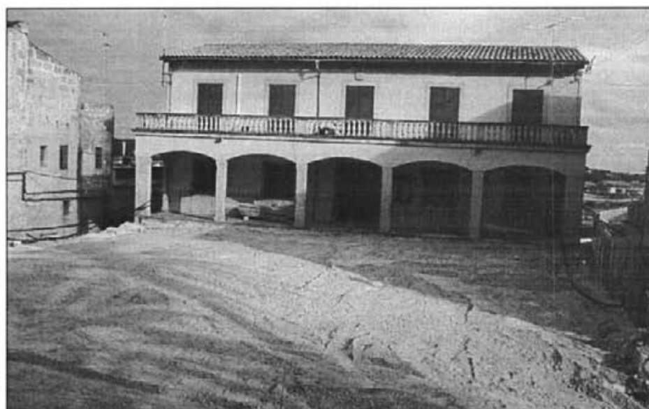
Així de despullada va romandre la plaça, sense arbres i amb el pis excavat
