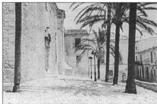
Els actuals graons foren construïts el 1813
