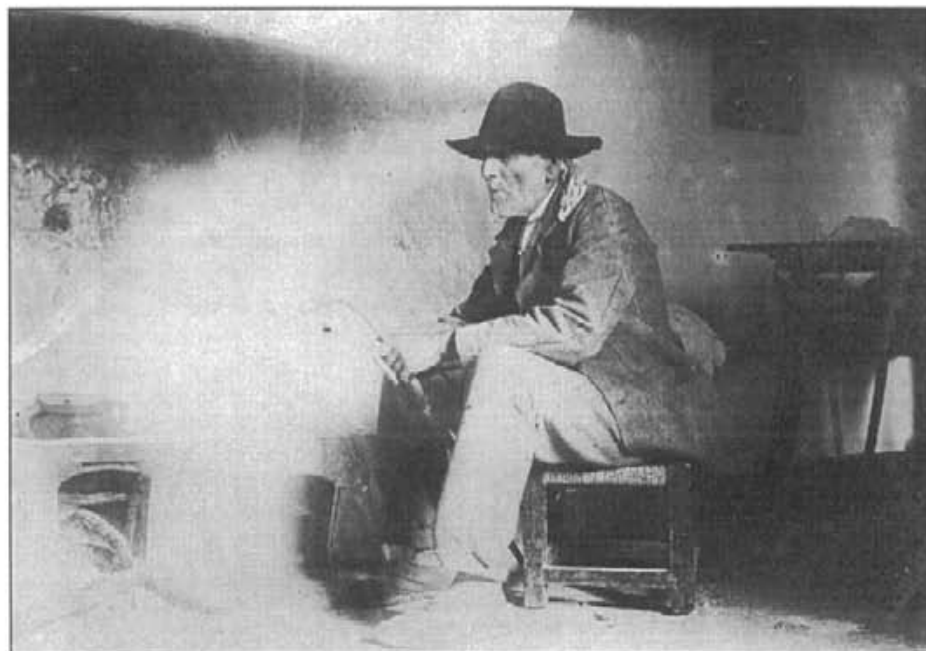
Un montuïrer escalfant-se al costat d'una foganya que a principis a segle tenien a Can Ferrando. Aquesta bella i antiga fotografia ens dóna una idea de com eren i anaven vestits els nostres avantpassats, com també ens indueix a la recerca dels diferents aspectes propis durant els 700 anys d'existència del nostre poble
