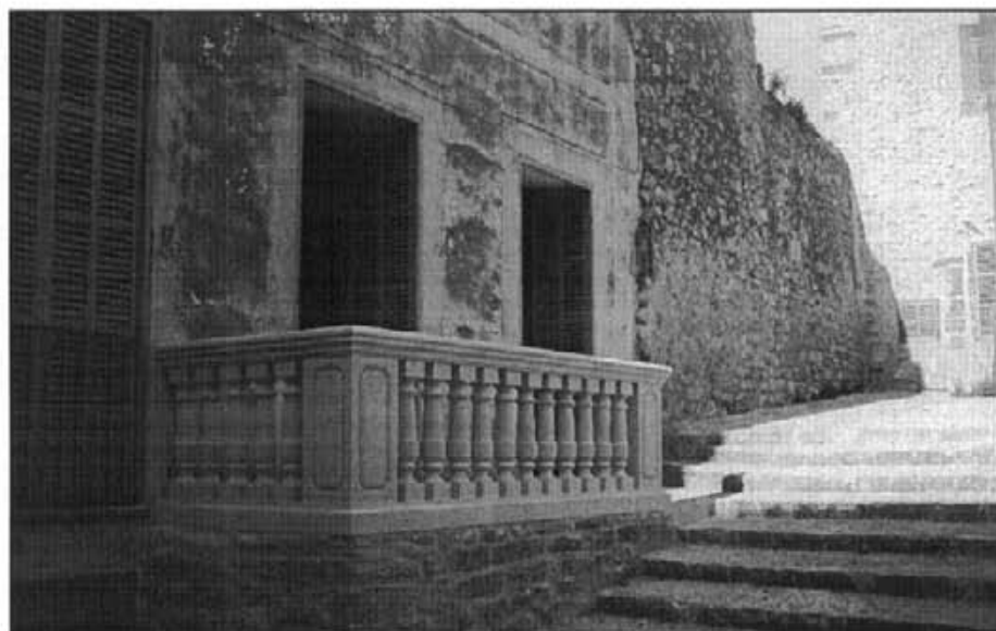
El lloc conegut pel "Balcó de sa Rectoria" ha estat renovat i notablement millorada la seva estructura amb una elegant balustrada
