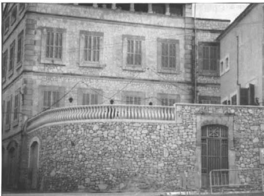
Façana de Ca ses Monges en l'actualitat. Futura residència
