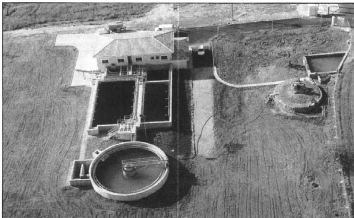
Vista aèria de depuradora inaugurada el passat 17 de maig pel President Cañellas. La inversió supera els 259 milions i pot servir una població de 6.000 habitants
