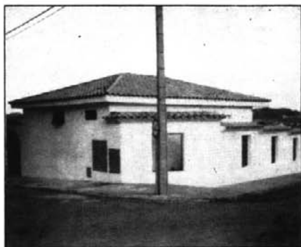
La nova central roman instal·lada en un edifici expressament construït, a l'acabament de l'avinguda Es Dau
