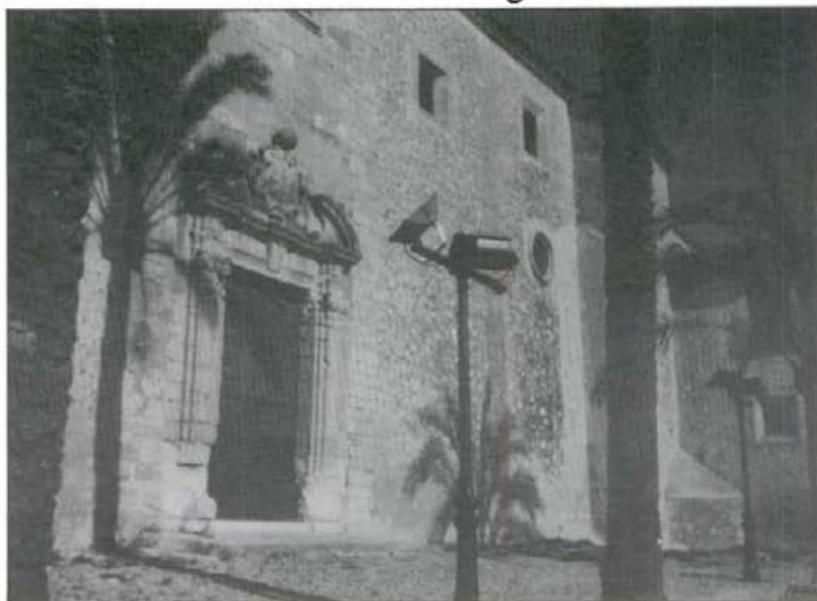
No han afavorit gens la imatge de l'església les faroles que s'hagueren de col·locar per il·luminar la seva façana. Molts consideren que també hagués anat bé un altre sistema
