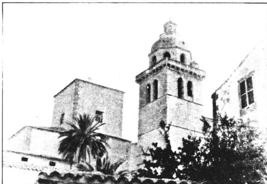
La decisió de la construcció de la capella del Roser, que s'aixeca airosa al costat del campanar, fou presa per l'Ajuntament el 6 de juliol de 1698
