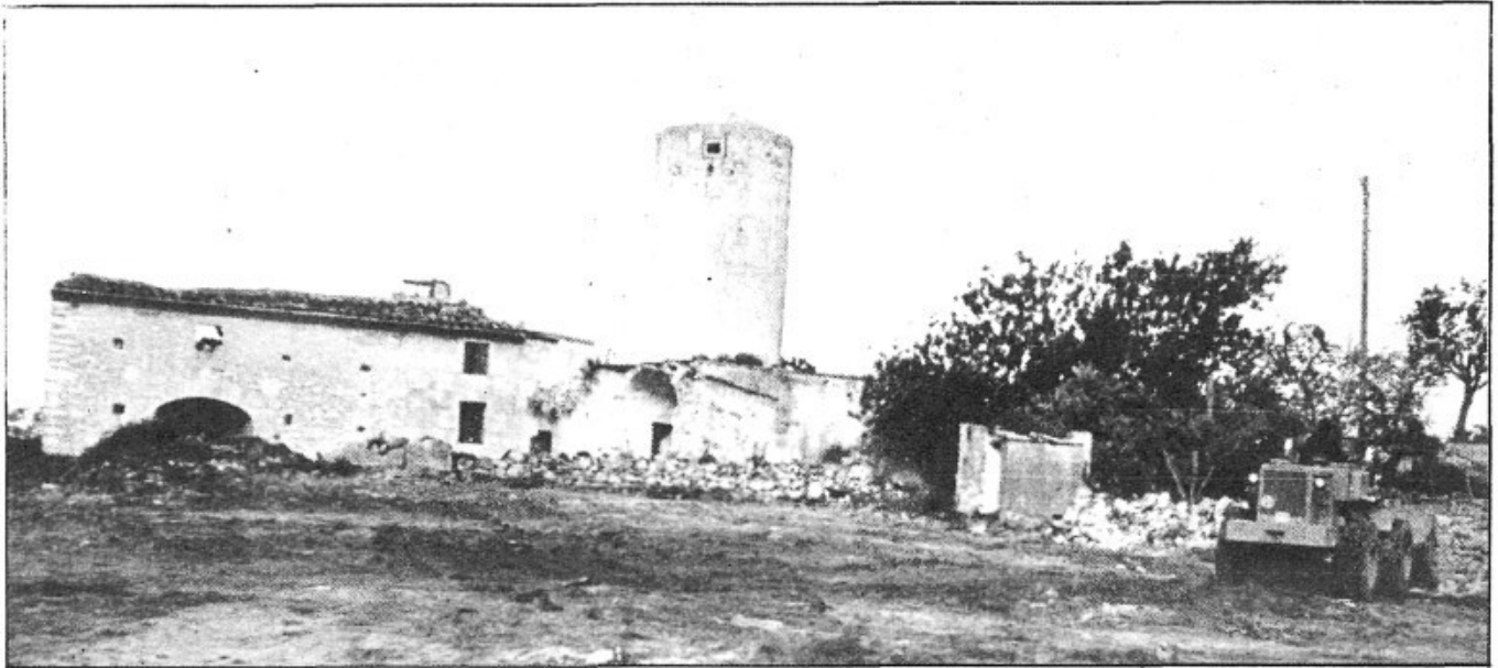
Aquesta foto ens mostra l'excavadora acabant la seva tasca davant el molí d'Es Fraret, preparant els terrenys pel nou parvulari, el març de 1985. Però fa 165 anys, diferents llamps varen arrassar altres molins que hi havia edificats i varen matar tres persones.
