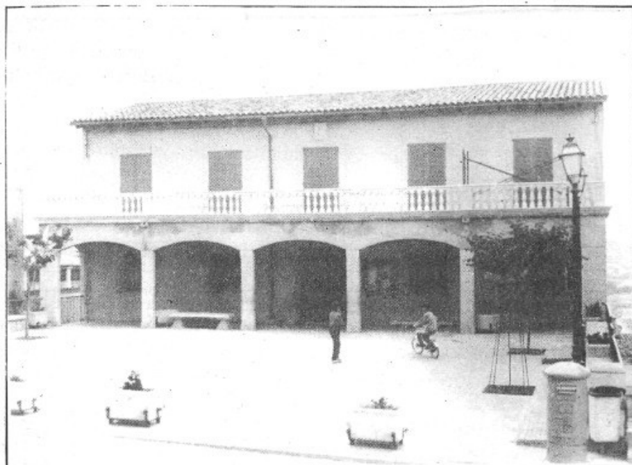
Façana i persianes pintades, els baixos forrats de pedra i arrambador nou al balcó. Vet aquí el "new look" de la nostra Casa Consistorial.
