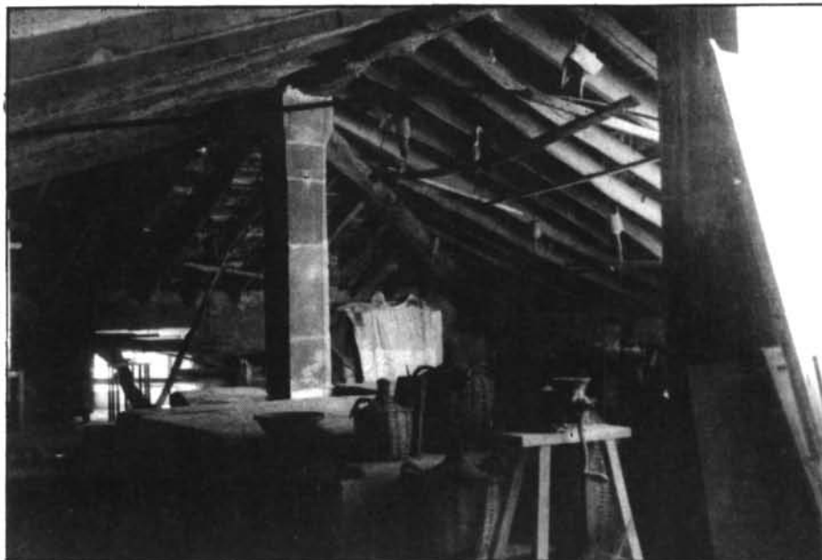
Conjunt del corbam molt ben entramat de les teulades de Ca Ses Monges, edificat l'any 1867.
